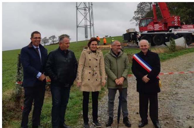
Levée pylône à Janailat le 17 octobre 2019
